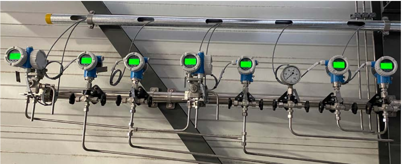
Nowe przetworniki Cerabar (ciśnienia procesu) i Deltabar (różnicy ciśnień) pracujące w spalarni odpadów.
