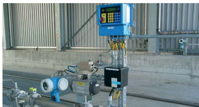
Stacja załadunku z przepływomierzem Promass F
