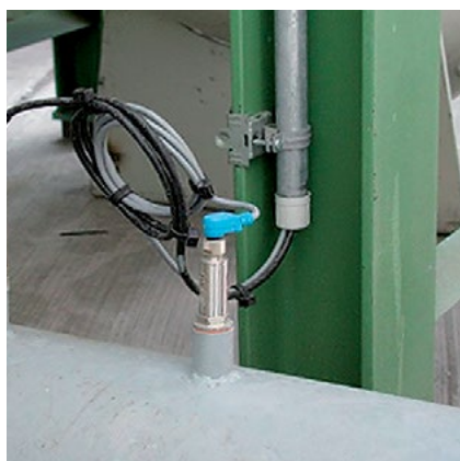
Monitorowanie rurociągów zasilających za pomocą termometrów kompaktowych oraz kompaktowych sygnalizatorów temperatury
