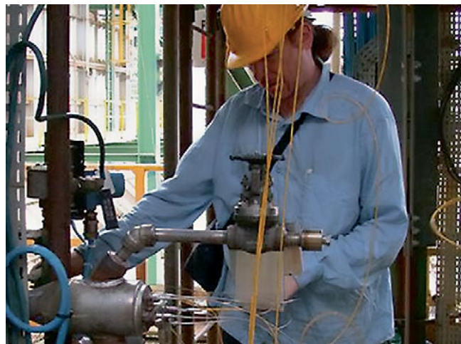
Konserwacja zainstalowanej komory rewizyjnej
