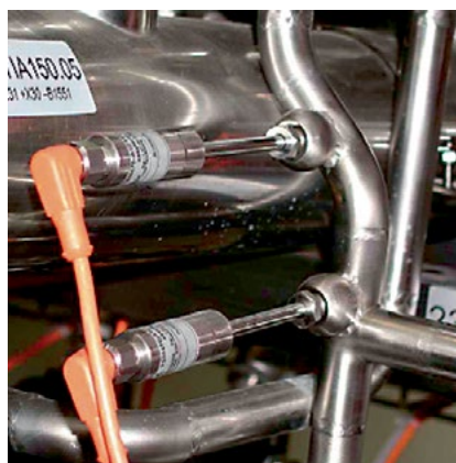
Monitorowanie rurociągów zasilających za pomocą termometrów kompaktowych oraz kompaktowych sygnalizatorów temperatury
