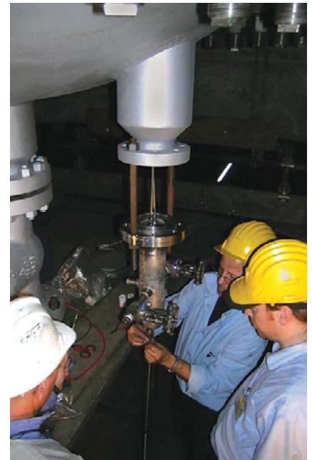
Montaż termopary wielopunktowej
