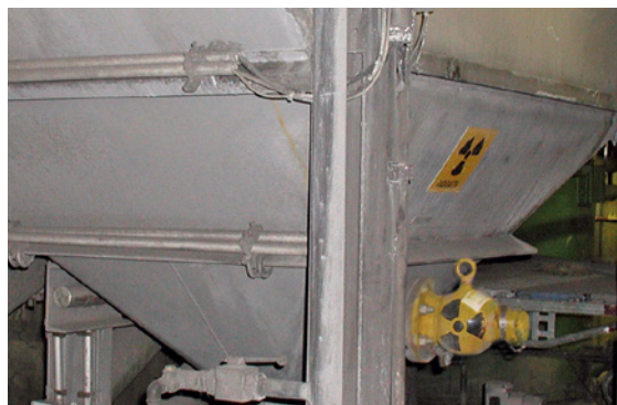
Gammapiłot w leju zasypowym filtra
