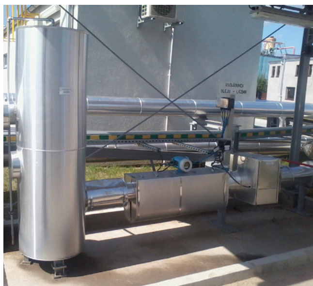
Instalacja przyjęcia oleju lekkiego z cystern kolejowych lub drogowych
