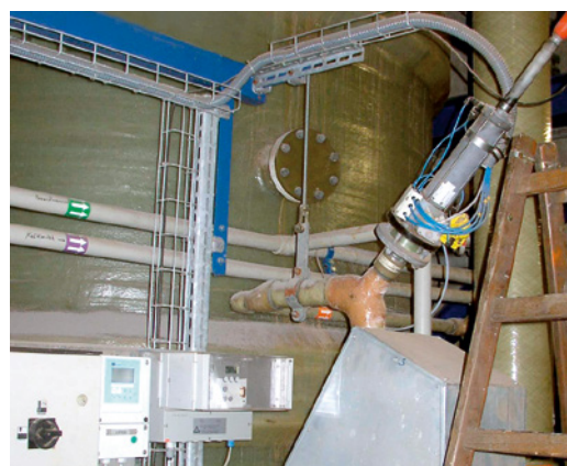
System automatycznego pomiaru pH, czyszczenia i kalibracji elektrod ze złączem Memosens
