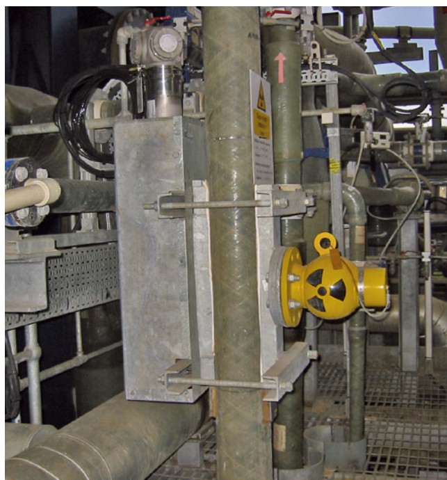
Przetwornik radiometryczny Gammapiłot w obiegu absorbera odsiarczania spalin
