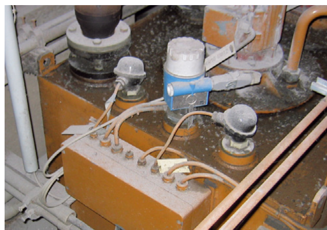
Pomiar poziomu w zbiorniku oleju smarnego za pomocą sondy Lquicap M
