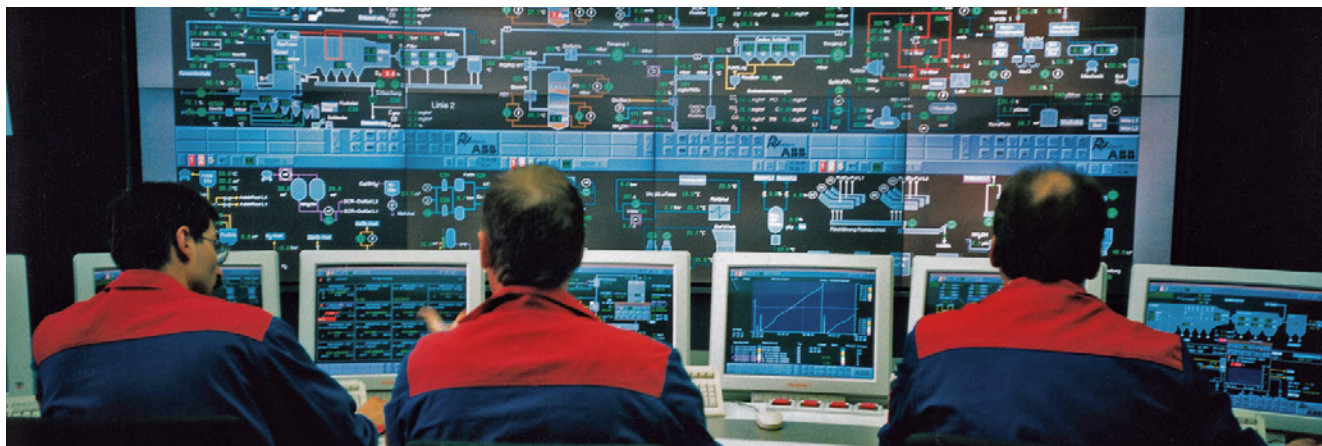
Nastawnia blokowa nowoczesnej elektrowni
