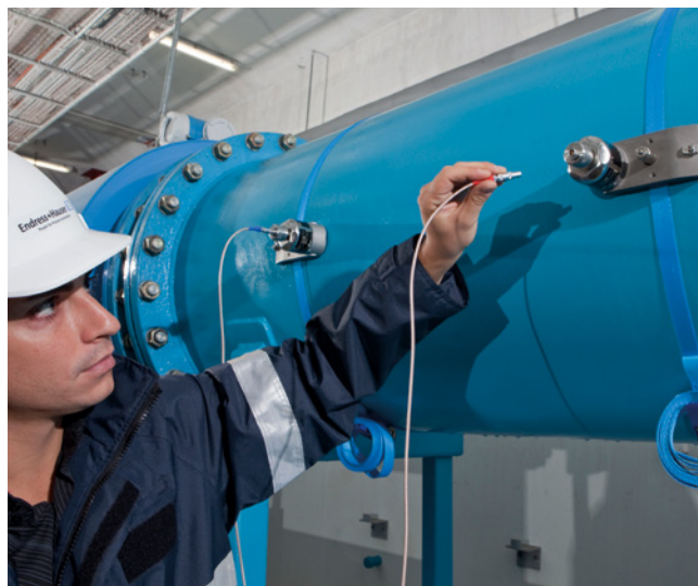
Przepływomierz Prosonic Flow na rurociągu wody chłodniczej
