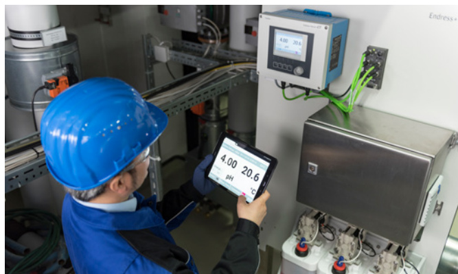
System automatycznego pomiaru pH, czyszczenia i kalibracji elektrod ze złączem Memosens
