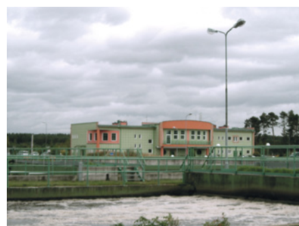
Oczyszczalnia Ścieków w Zielonej Górze
