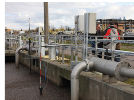
Zainstalowany układ pomiarowy
