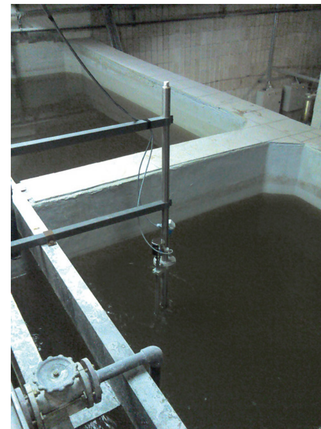
Czujnik wibracyjny Liquiphant Density i czujnik temperatury Omnigrad M TR10 w zbiorniku roztworu siarczanu glinu
