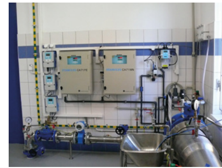
Kontrola stężenia żelaza i manganu na wylocie SUW
