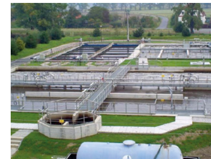
Oczyszczalnia ścieków w Chełmie
