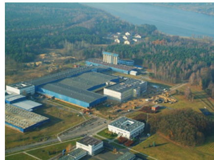
Wodociąg Warszawskie, Zakład Wodociągów Północnego w Wieliszewie
