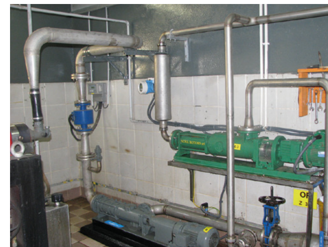
Układ dozowania polielektrolitu do wirówek wykorzystujący przepływomierze elektromagnetyczne Endress+Hauser Promag 50P
