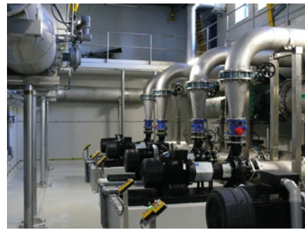
Pomownia wody surowej do filtrów
