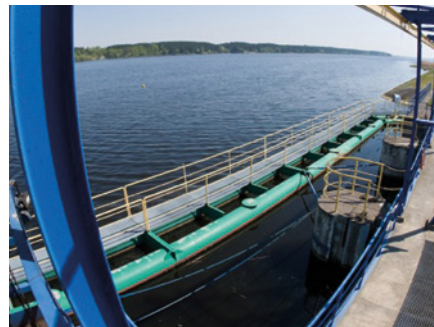
Zakład Wodociągów Północnego w Wieliszewie
