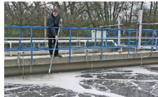
Czujniki tlenu i gęstości osadu w komorze biologicznej
