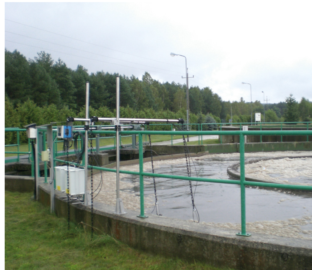
Widok urządzeń zainstalowanych na oczyszczalni ścieków
