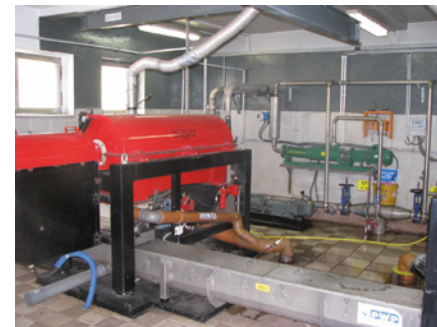
Układ dozowania polielektrolitu do wirówek
