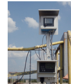
Przetworniki pomiarowe na obiekcie
