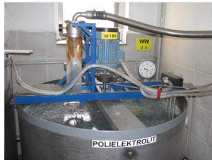
Zbiornik zawierający roztwór polielektrolitu
