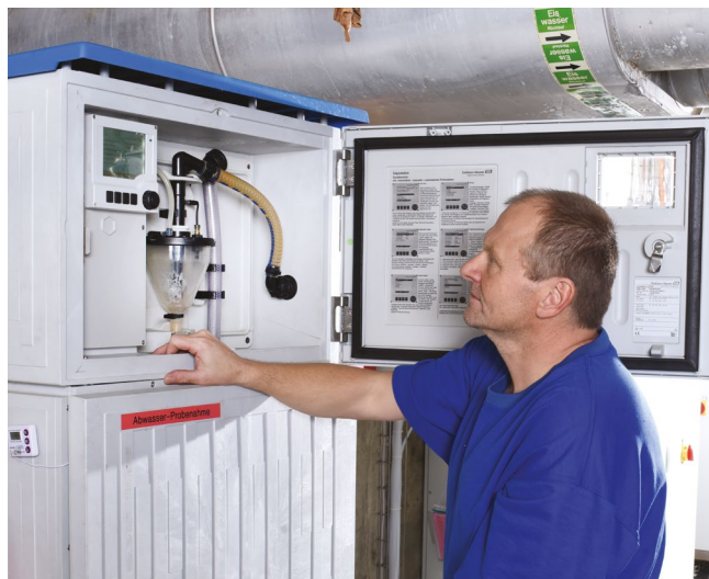
Pobór próby z rurociągu.
