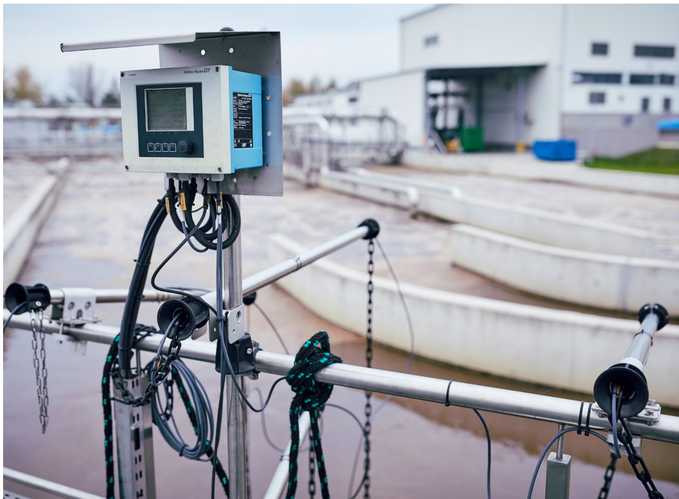
Zestaw sond do pomiaru tlenu oraz azotu w odpływie z reaktora biologicznego.
