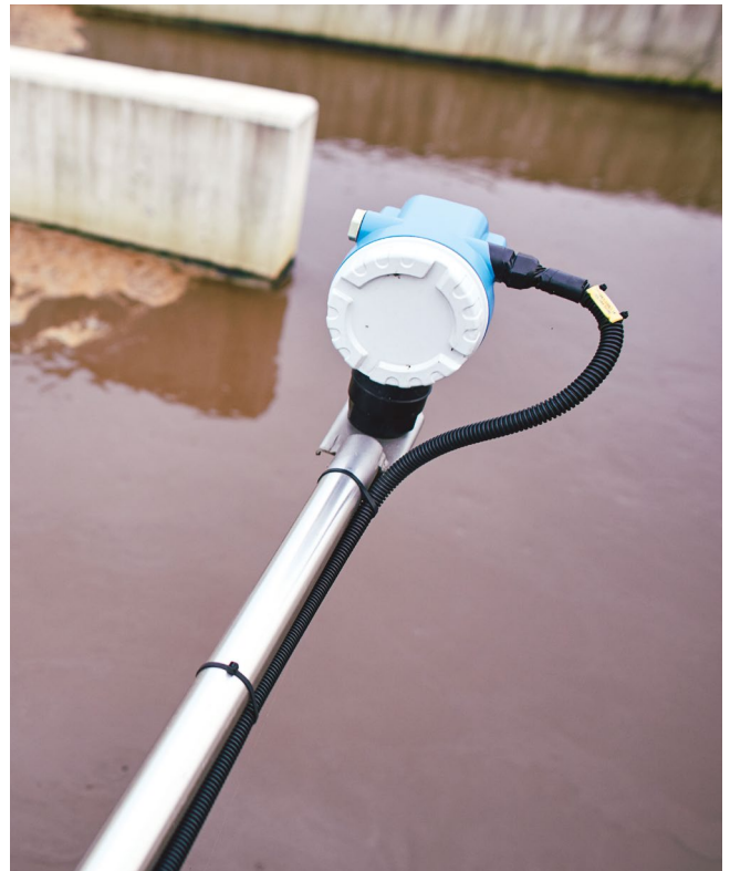
Sonda ultradźwiękowa z komunikacją Profibus PA.
