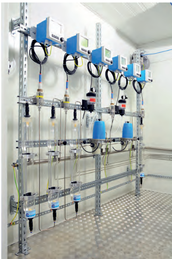
Rys. 3. Przetworniki Liquiline do pomiaru odczynu pH, przewodności i tlenu rozpuszczonego, prod. Endress+Hauser
