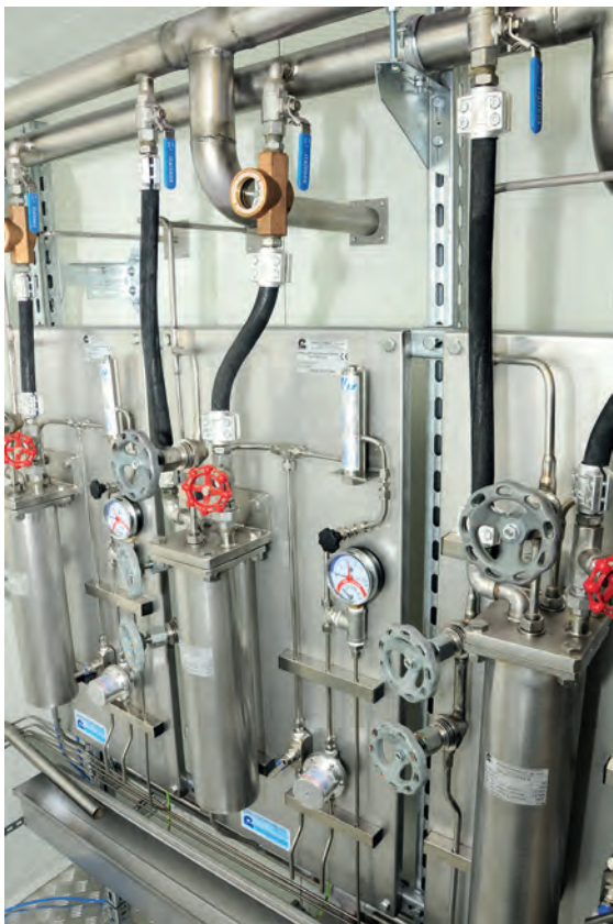
Rys. 2. Kompletny panel poboru i chłodzenia próbki, prod. ENERGOPOMIAR
