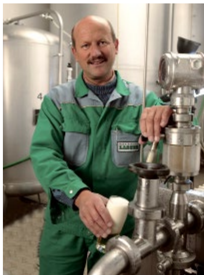
Cerabar M PMC51 z czujnikiem ceramicznym
