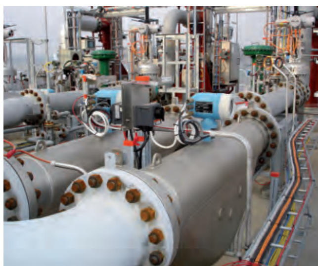
Instalacja przepływomierza Promass na istniejącej platformie przeładunkowej zamiast poprzednio stosowanego przepływomierza turbinowego i filtru
