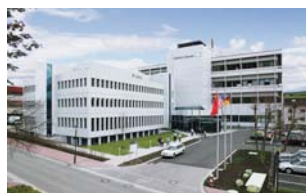
Zakład Produkcyjny PC Maulburg, Maulburg (Niemcy) Badania i rozwój, produkcja, kalibracja Przetworniki poziomu, ciśnienia i systemy dla zbiorników legalizowanych
