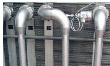
Dwa czujniki temperatury w jednym punkcie pomiarowym: temperatura kontrolowana przez Omnigrad TR47 z podwójnym czujnikiem PT100
