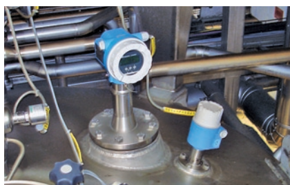
Micropilot M FRM245: Radarowy pomiar poziomu w zbiorniku ciśnieniowym do przygotowywania przetworów owocowych
