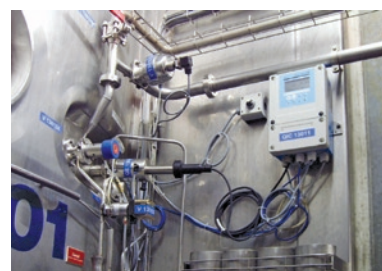
Wysuwalna armatura pH Cleanfit H w zbiorniku do dojrzewania sera
