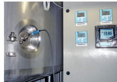
Stala armatura dla sondy pH Unifit H w zbiorniku z hodowlą bakterii
