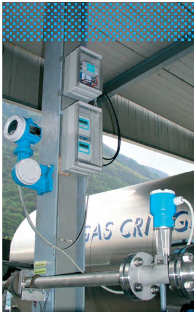
Monitorowanie poziomu i dozowanie z wykorzystaniem dwóch rejestratorów Minilog B.
