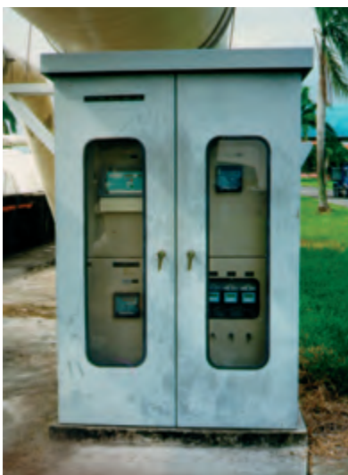
4 rejestratory Minilog B pracujące na wlocie dużej oczyszczalni ścieków w południowo-wschodniej Azji.
