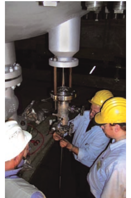
Montaż termopary wielopunktowej
