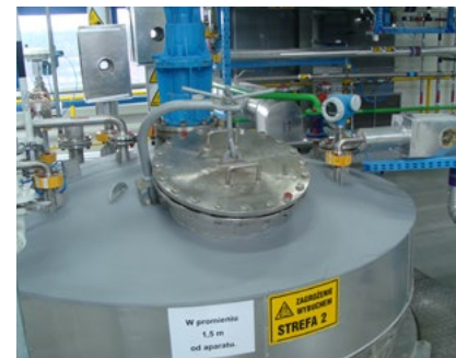
Radar bezkontaktowy Micropilot w reaktorze technologicznym
