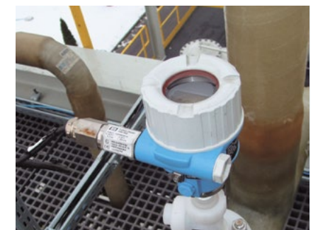
Przetwornik ciśnienia Cerabar PMC51 z czujnikiem ceramicznym, kołnierzem z PVDF i ochronnikiem HAW569
