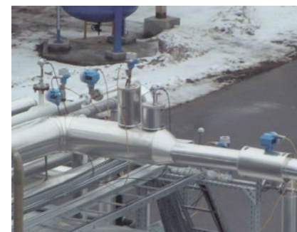
Przepływomierze Prowirl 72F i przetworniki ciśnienia Cerabar PMP51
