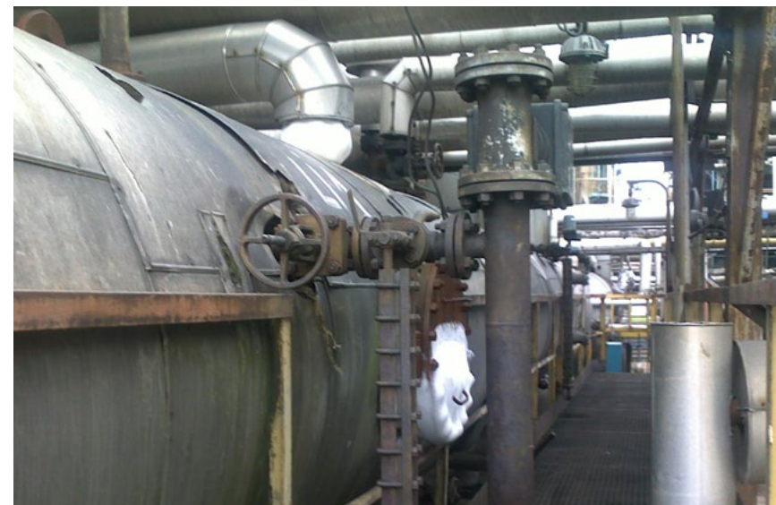
Uszkodzony, nurnikowy pomiar poziomu mieszaniny deparafinatu, DIME i propanu
