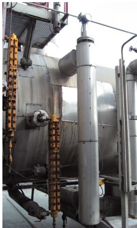
Radar z falowodem Levelflex w wychładzalniku amoniaku Jednostki Biznesowej NITRO
