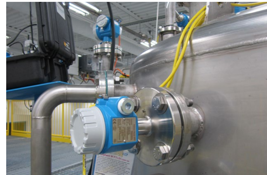
Wibracyjny sygnalizator poziomu cieczy Liquiphant FailSafe SIL3 w blokadzie ESD, chroniącej zbiornik przed przepełnieniem
