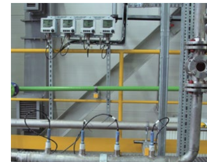
Układy pomiarowe pH/redoks z Liquiline CM42 i Orbisint CPS11D Memosens
