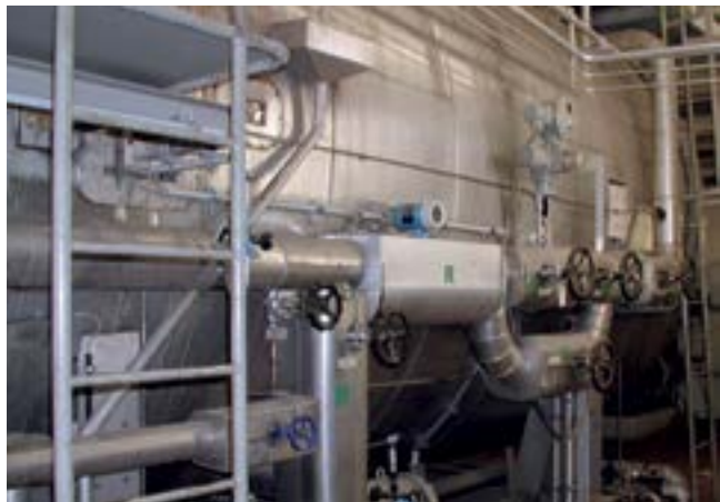
Pomiar zużycia oleju rozpałkowego przez palniki za pomocą przepływomierzy Promass 84F z certyfikatem MID
