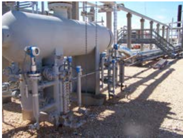
Separator woda/węglowodory po modernizacji pomiaru poziomu i rozdzielenia faz z użyciem radarów Levelflex
