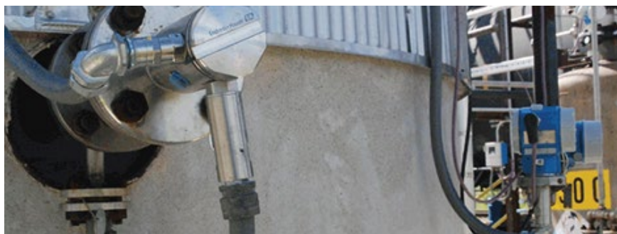
Czujnik wysokiego ciśnienia systemu Deltabar FMD72 – mierzy ciśnienie hydrostatyczne i nadciśnienie
