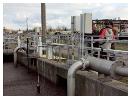
Zainstalowany układ pomiarowy
