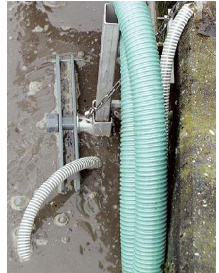
Płyta filtracyjna systemu StamoClean CAT430 zanurzona w komorze osadu czynnego
