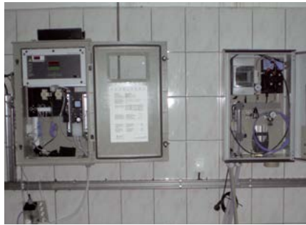
Analizator CA71COD i sytem filtracji ETL
