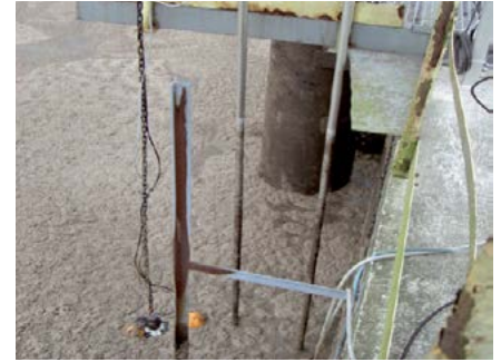
Sonda ISEmax w armaturze pływającej
