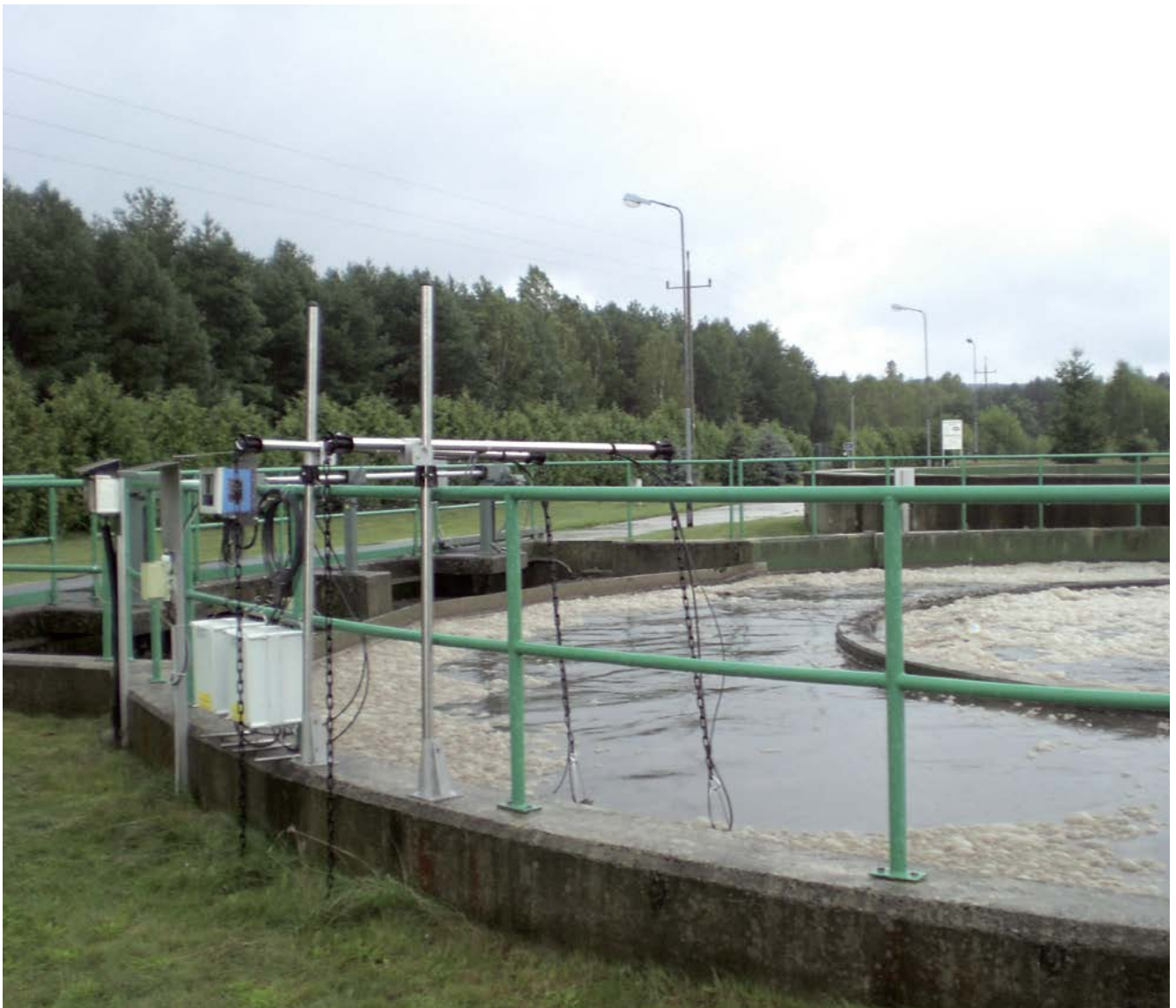
Widok urządzeń zainstalowanych na oczyszczalni ścieków
