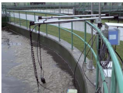
Zainstalowany układ pomiarowy
