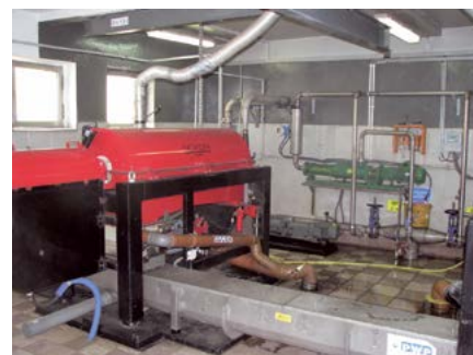
Układ dozowania polielektrolitu do wirówek
