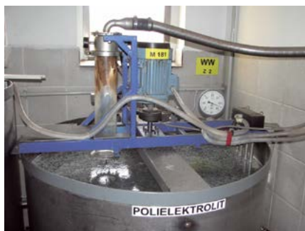
Zbiornik zawierający roztwór polielektrolitu
