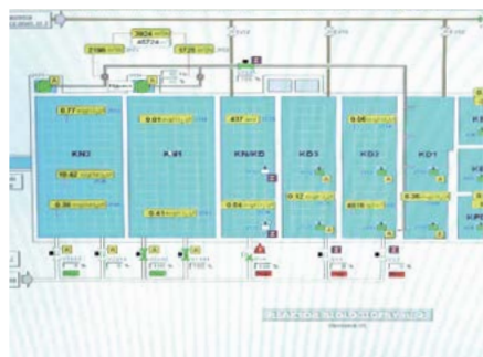
Reaktor biologiczny w oczyszczalni ścieków „Jamno” w Koszalinie
