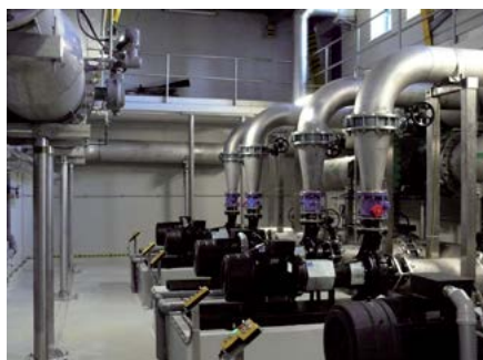
Pompownia wody surowej do filtrów
