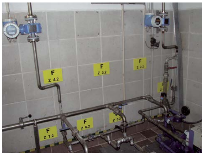
Pomiar gęstości osadu niesionego przez wodę w układzie bypass
