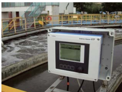
Przetwornik Liquiline M CM442 z dwoma czujnikami: gęstości osadu oraz potencjału redoks
