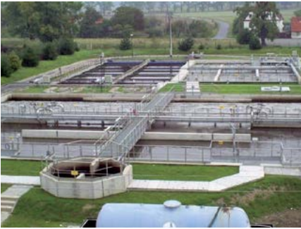
Oczyszczalnia ścieków w Chełmie
