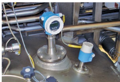
Micropilot M FMR52: radarowy pomiar poziomu w zbiorniku ciśnieniowym do przygotowywania przetworów owocowych
