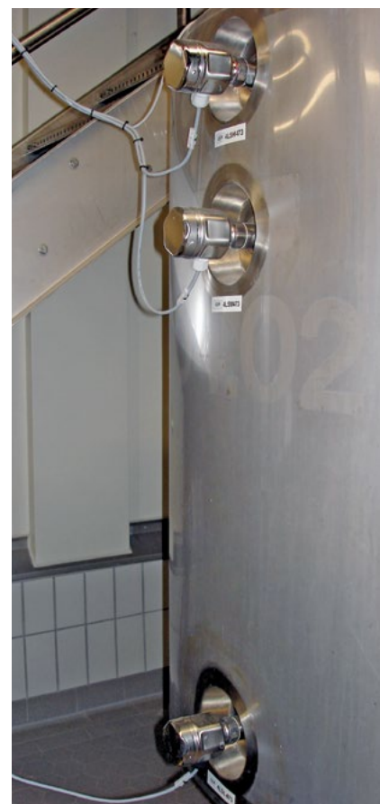
Magazynowe zbiorniki przejściowe: sygnalizatory poziomu Liquiphant M
