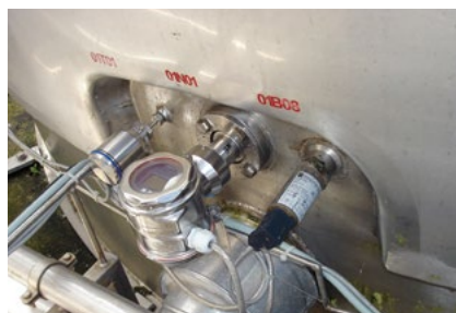
Zbiornik magazynowy: pomiary temperatury oraz poziomu mleka
